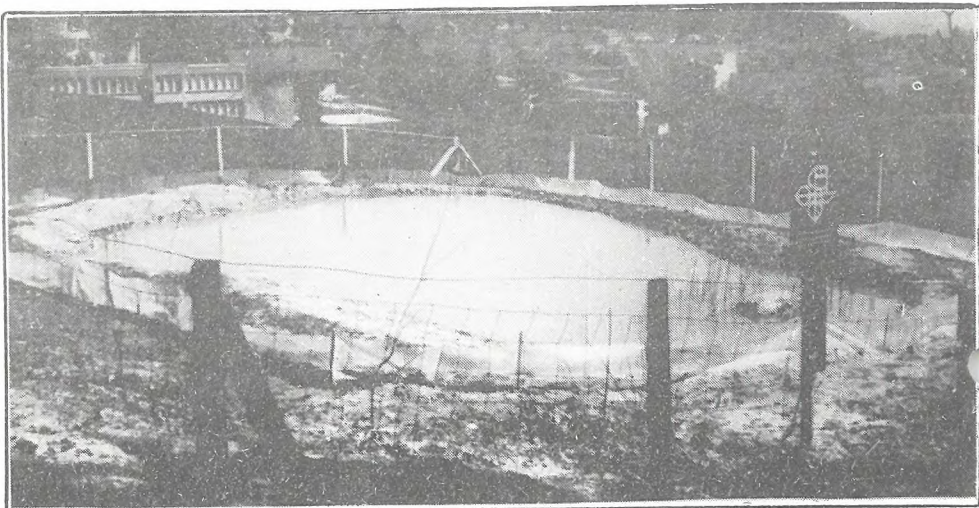
Frühjahr 1984: Unmittelbar nach der Fertigstellung des Langhaldeweiher
